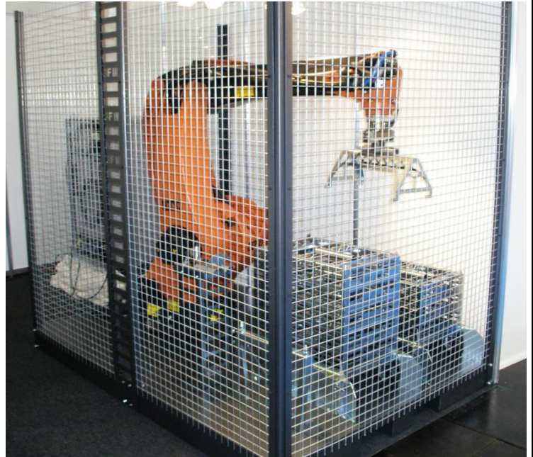
Auto line /4x2 Zugang vorne, Automationszelle mit Schutzzaun
